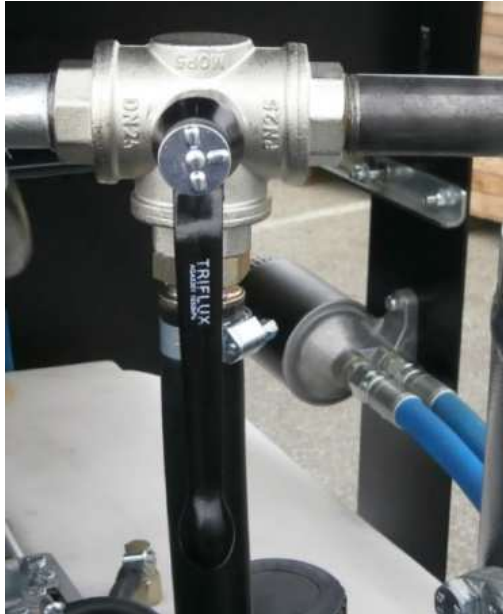
Configuration en position refroidisseur final désactivé (circuit 1)
